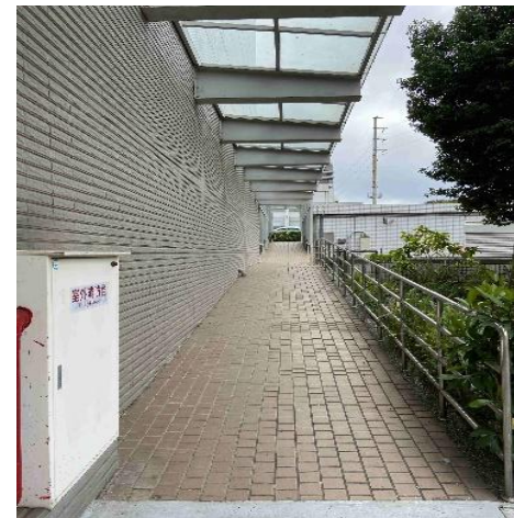
廠區無障礙坡道
